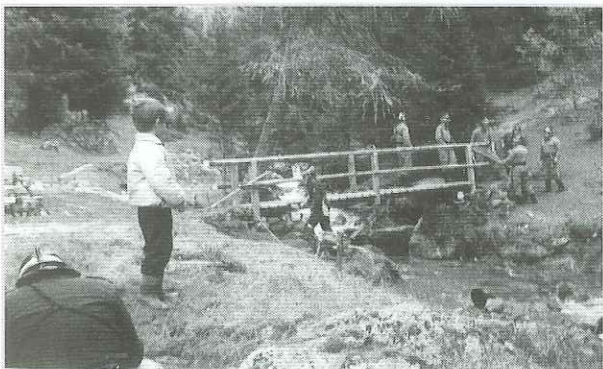
Der Jungbauer vom Renzlerhof, links, bei der Bauaufsicht
