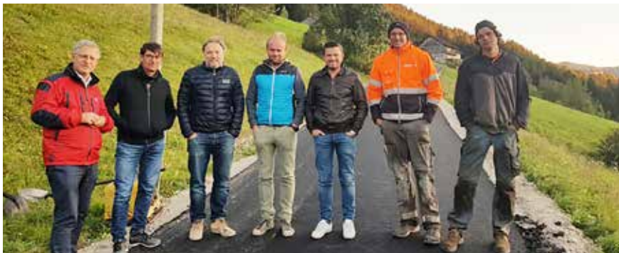
Lokalaugenschein Sanierung Zufahrtsstraße Mitterberg
