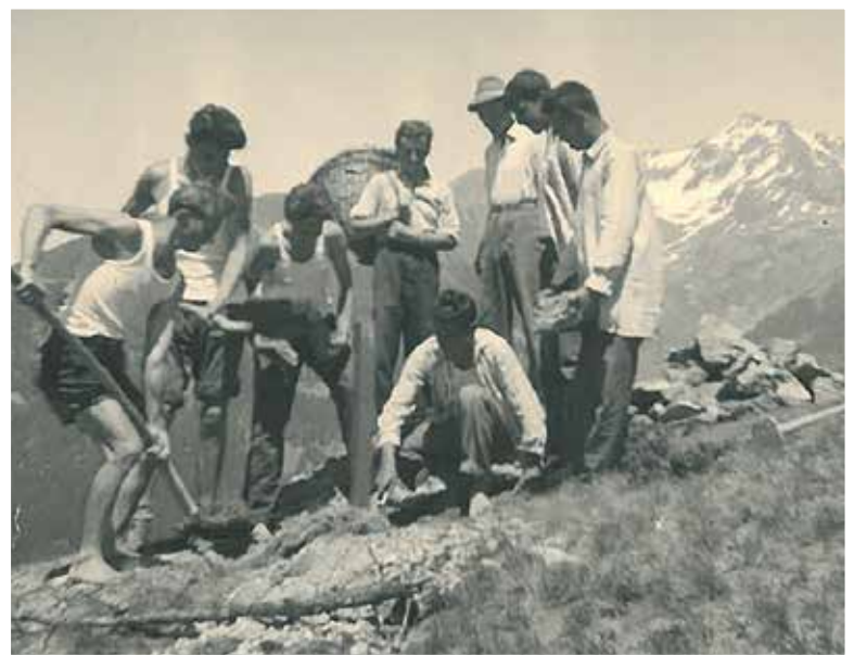
Der Sockel des Kreuzes wurde betoniert.
