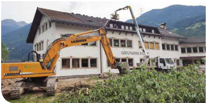
Abbruch der Grundschule in Gais.
