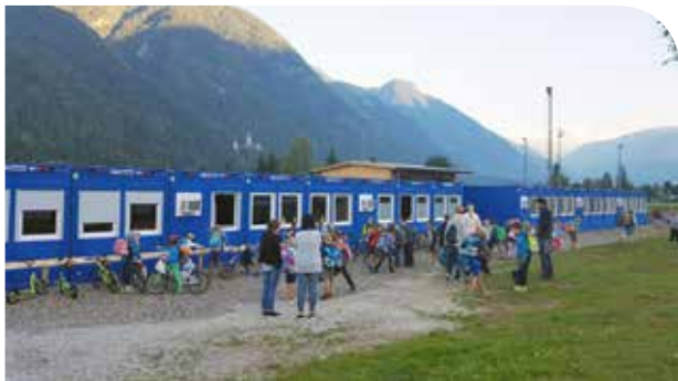
Die Containerschule in Gais.
