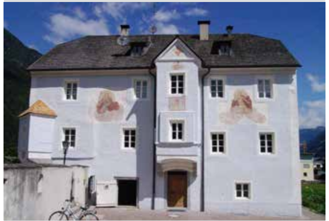
Nach der Restaurierung
