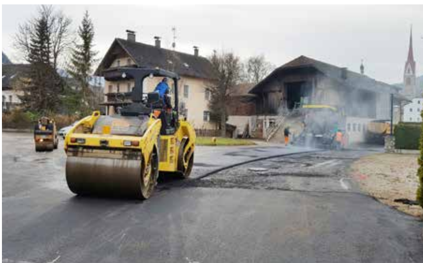
Asphaltierung der Kehlburgstraße
