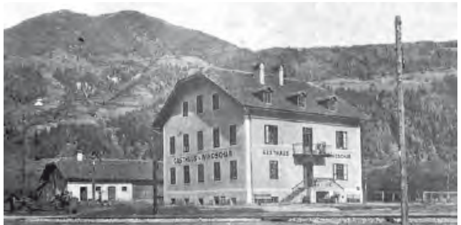
Gais: Gasthaus „Windschar“ (1908) an der Trasse des Tauferer „Bahnls“ Die Bahn Bruneck–Sand in Taufers war von 1908-1957 in Betrieb.
