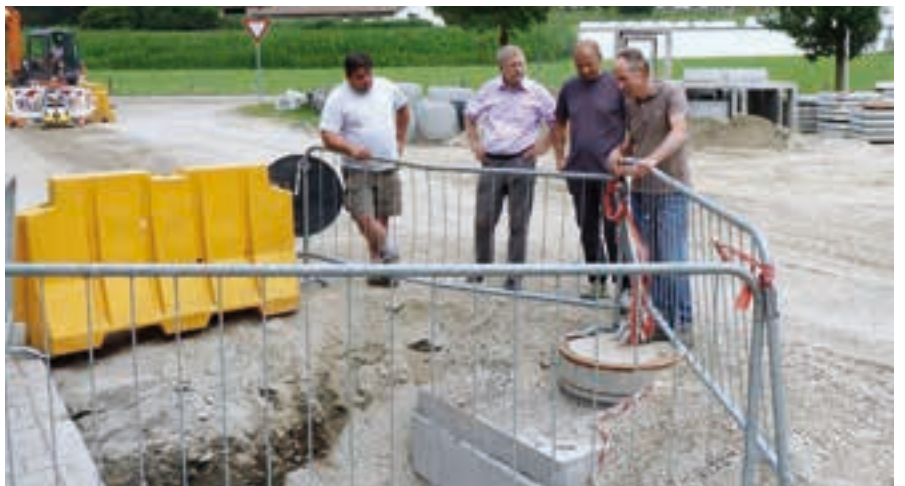
Baumeister Erich Auer, Gemeindesekretär Eugen Volgger, Referent Othmar Hellweger, Referent Heinrich Untergasser (v.l.n.r.) bei der Baustelle im Bereich des Vereinshauses
