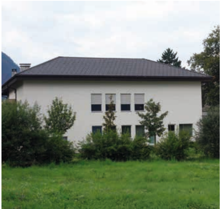
Pfarrheim Gais: neues Dach
