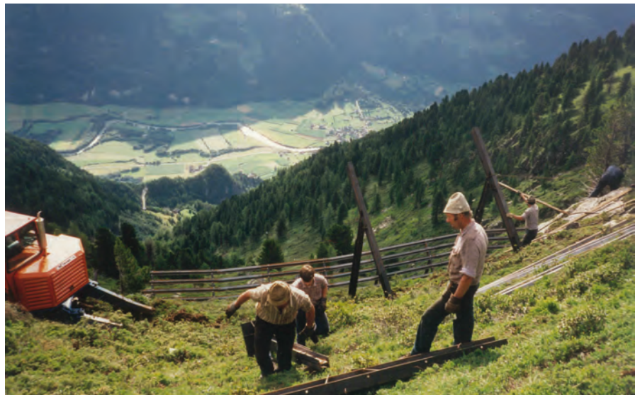
Bild 17: ...der Schreitbagger wurde zerlegt und per Hubschrauber heraufgebracht
