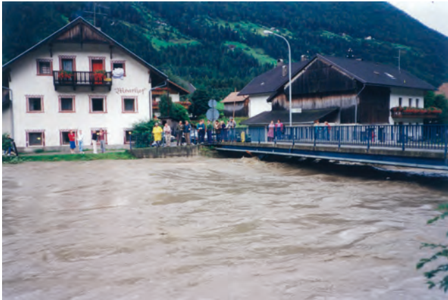
Bild 8: Die neue Brücke von 1976 hat größeren Durchfluss.
